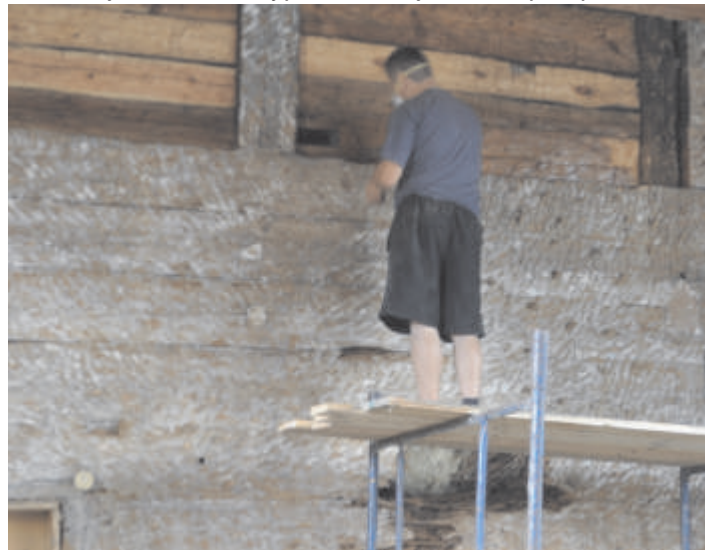
Prace konserwatorskie - prezbiterium
