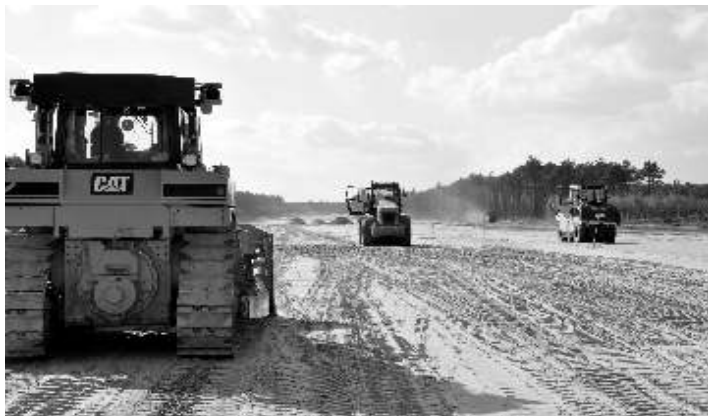
Budowa autostrady A2 w okolicach Rogoziem
