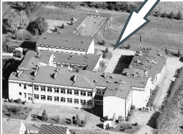
Miejsce budowy Centrum Kultury i Folkloru w D brówce Wlkp.
