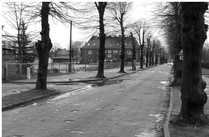
ul. Sportowa - przed remontem
