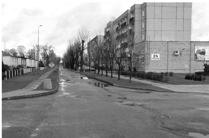
ul. Topolowa - przed remontem
