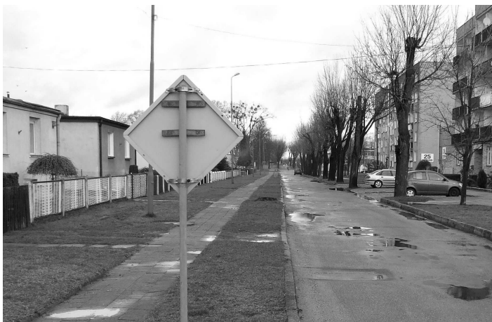
ul. Topolowa - przed remontem
