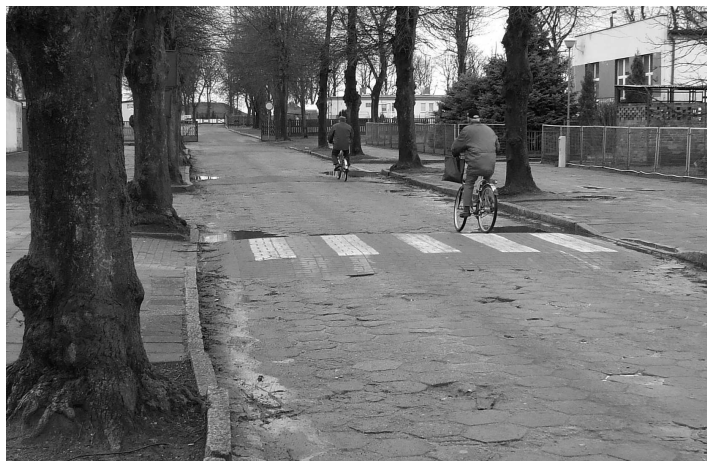
ul. Sportowa - przed remontem
